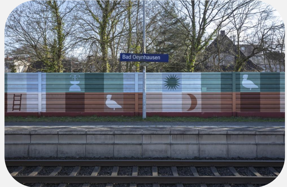
Beispiel Gestaltung Lärmschutzwand. Deutsche Bahn AG / Axel Hartmann Fotografie
