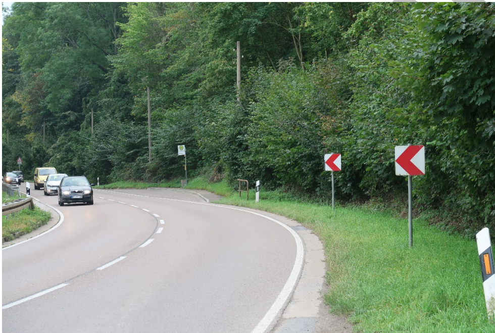
Staatsstraße 172 im Bereich einer möglichen Querung mit der Neubaustrecke
