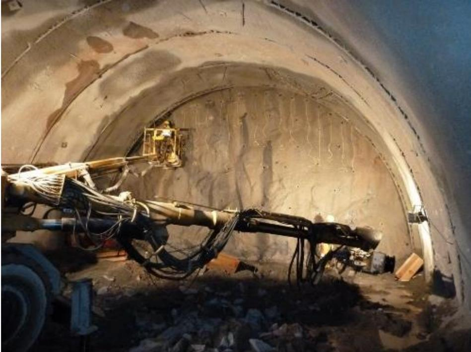
Abbildung 34: Tunnelherstellung im Sprengvortrieb - Herstellung der Sprenglöcher (Foto: K+K)
