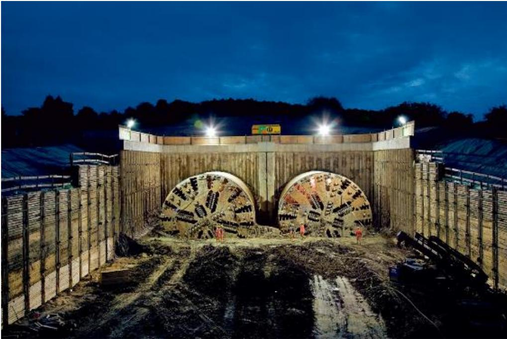
Abbildung 35: Durchbruch beider TVM am Katzenbergtunnel (Foto: Firma Herrenknecht [8])
