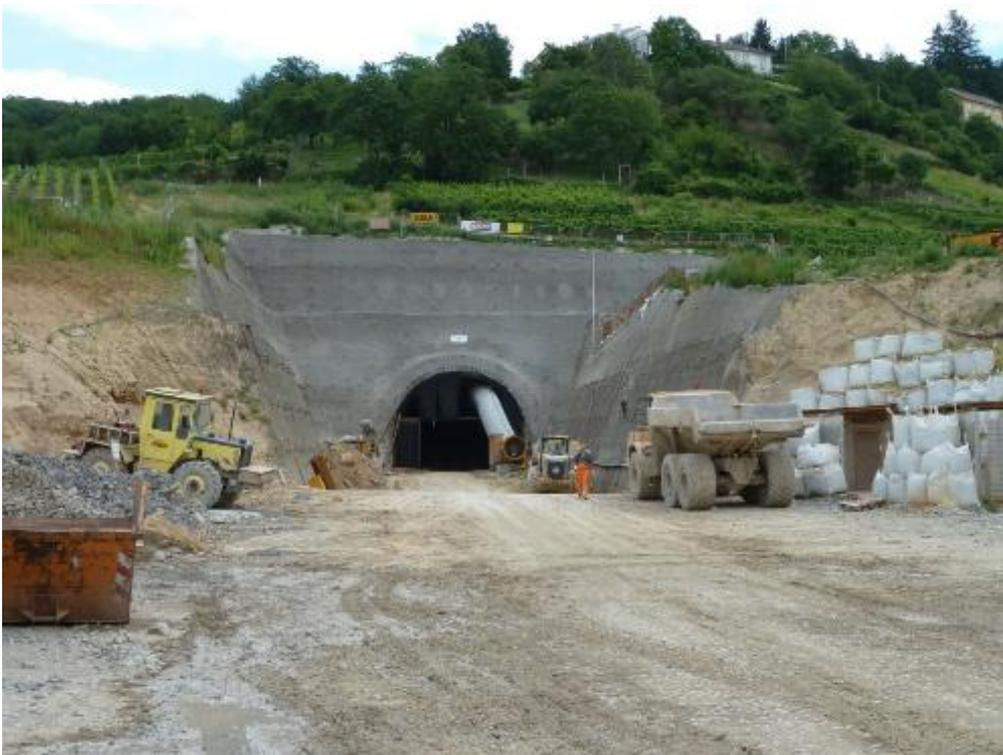
Abbildung 33: Voreinschnitt, Spritzbetonsicherung mit Verpressankern (Foto: K+K)
