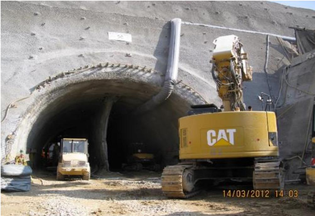
Abbildung 32: Tunnelanschlagswand, bergmännische Bauweise, Sicherung mit Rohrschirm, geteilte Kalotte
