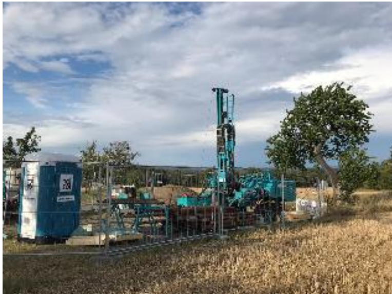
Bohrplatz Pflaumenallee in Heidenau (DB AG/Jan Frintert)
