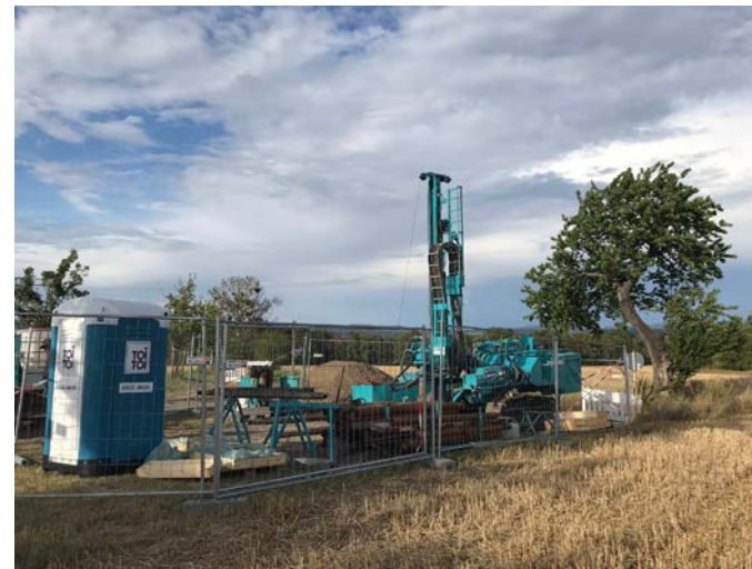
Bohrplatz Pflaumenallee in Heidenau (PRUY GmbH)
