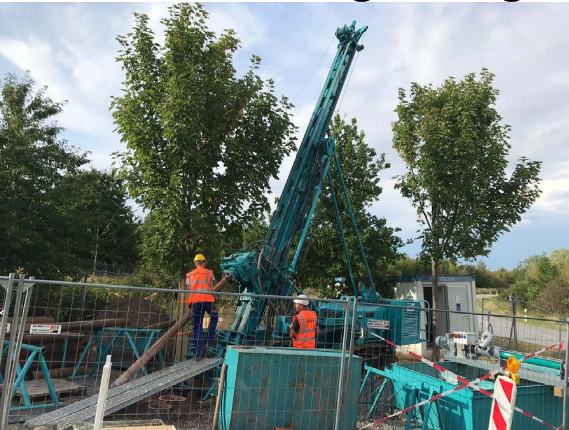
Bohrplatz Kreuzung Alte Dresdner-Teplitzer-Poststraße/Borna an der BAB 17 in Bahretal (Pruy GmbH)
